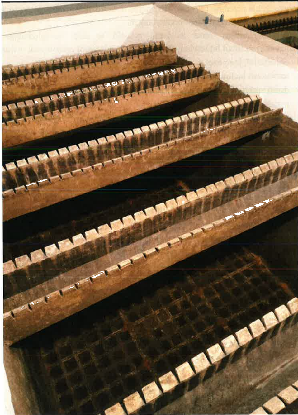
Fot.1 Widok komory filtracyjnej
